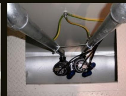
N.2 elettropompe di sentina portata 10 mc/h, di cui una autoalimentata rif. punto 6.3.2 e sonda di presenza acqua a pavimento
