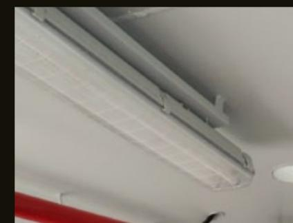
Lampada di servizio (min. 200 lux) e luce di emergenza (min. 25 lux per 60 min.) rif. punto 6.2.1
