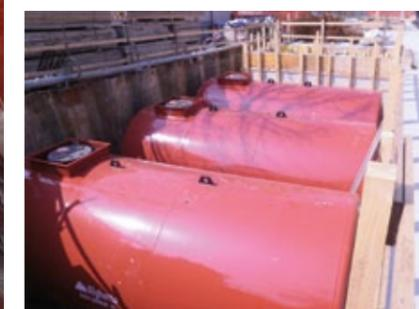
Serbatoi per impianto di cogenerazione per l'auto produzione di energia elettrica.
