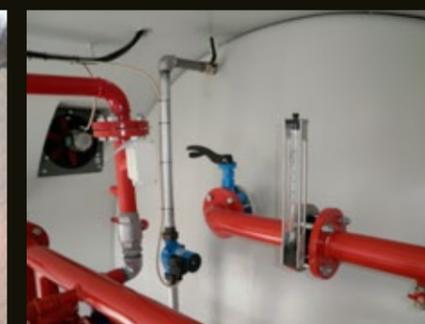
Particolare del misuratore di portata per il circuito di controllo settimanale e kit sprinkler a norma UNI EN 12845
