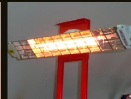
Riscaldatore elettrico da 2000 w. atto a mantenere una temperatura minima di 15°C rif. punto 6.4
